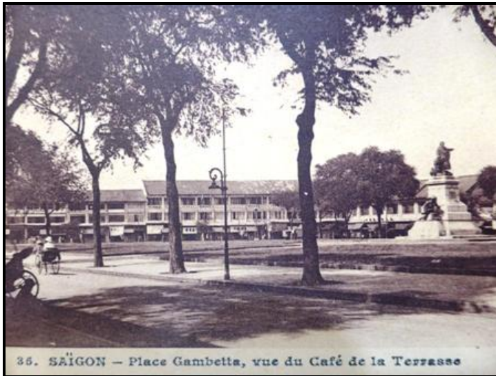
Công trường Gambetta nhìn từ quán Café de la Terrasse (khoảng 1922)
