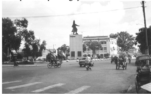
Công Trường Mê Linh
